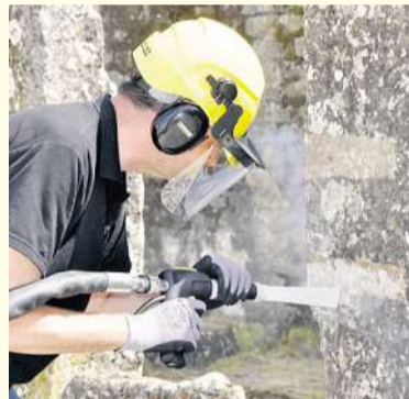
Die Trockeneispellets prallen auf die antiken Kalksteine und entfernen den Schmutz, ohne Rückstände zu hinterlassen oder die Oberfläche zu beschädigen.
